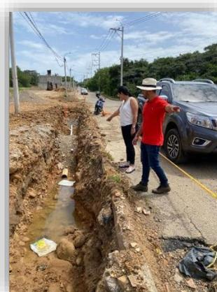
Fotografías 5 y 6 tubería de red pluvial en mal estado, colapsado, agua estancada y malos olores en el sitio
