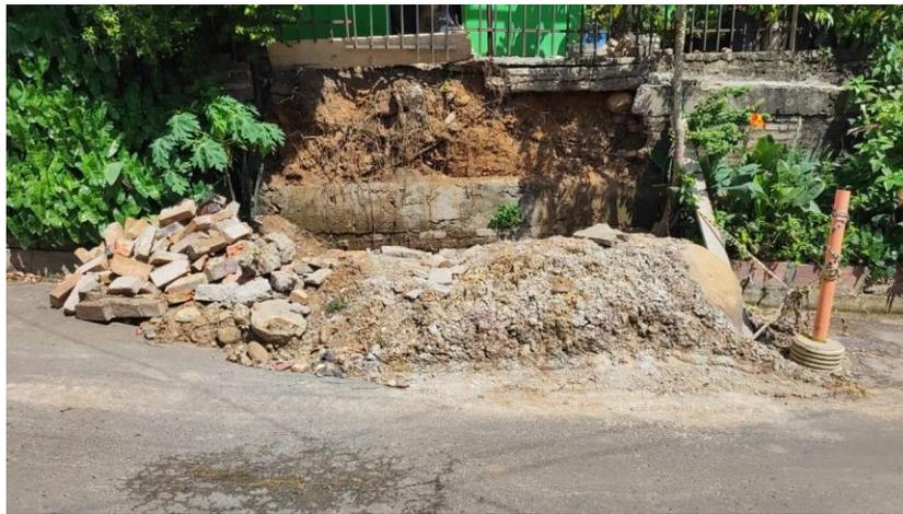
Fotografía 1 talud intervenido por el propietario para acceder a la tubería averiada
