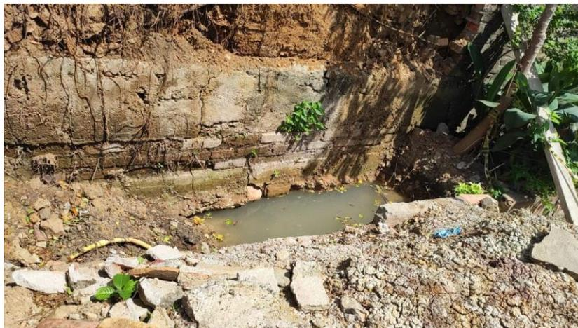
Fotografía 2 filtración y encharcamiento de agua debido a la tubería averiada
